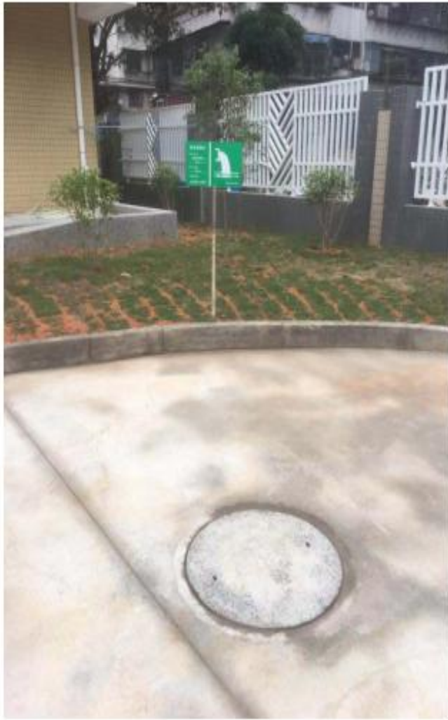
废水总排放口
