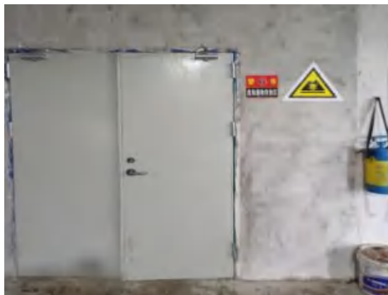
一般固废暂存间
