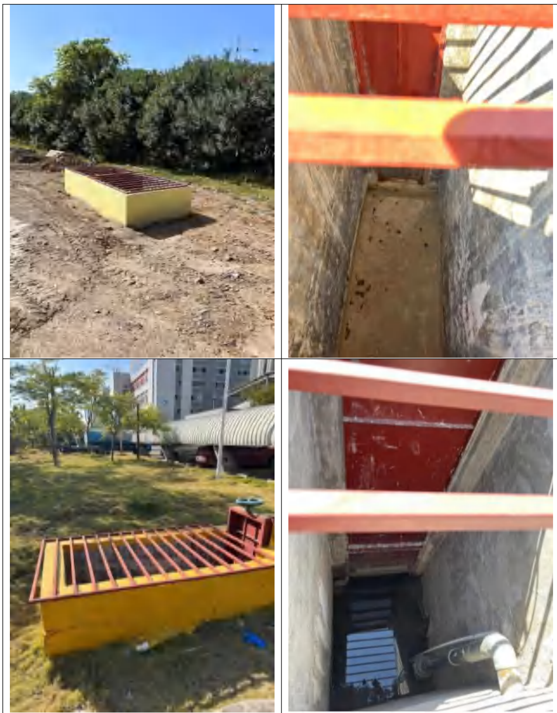
图 3.1-17 表处园雨水管道风险防控改造图
