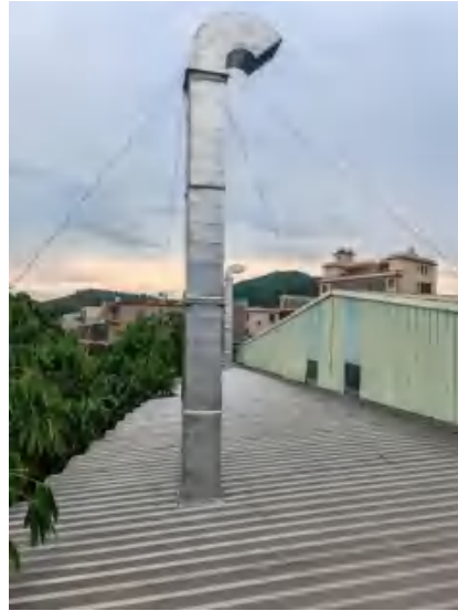
废气排放口（及处理设施、废气收集管道）
